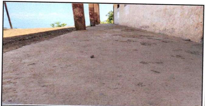
**Foto 6:** Se puede observar que el piso ya está con demasiados agujeros tanto dentro y fuera del aula, debido a que la torta de cemento ya no está en buenas condiciones.
